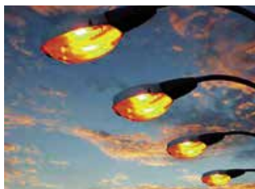
Уличные фонари с натриевыми лампами
